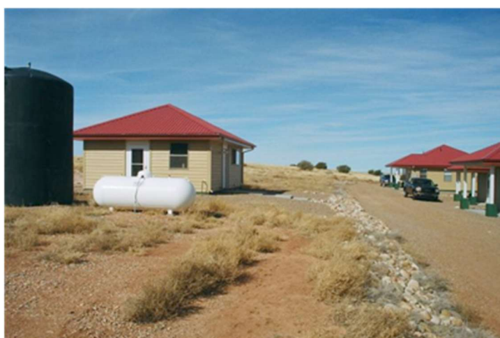
El edificio mecánico (izquierda) con el tanque de agua y tanque de propano.
